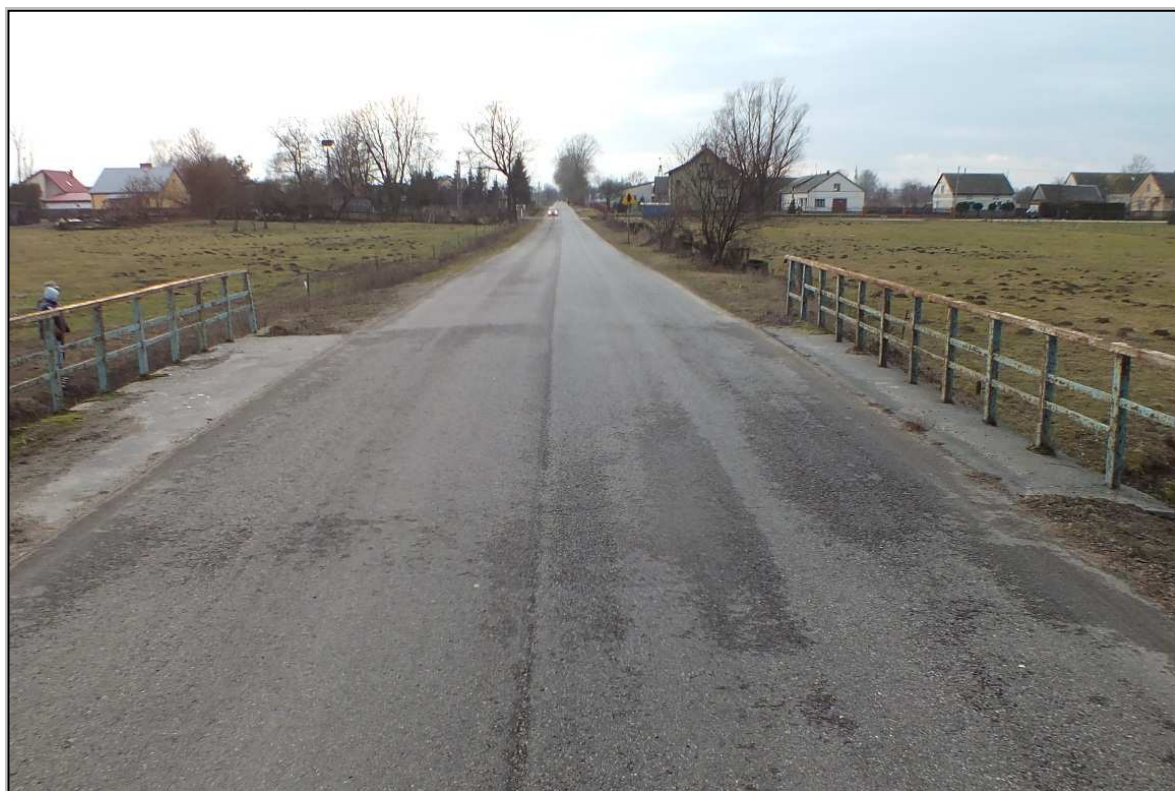
Rys. 2.3 Widok na obiekt od strony Myszała
