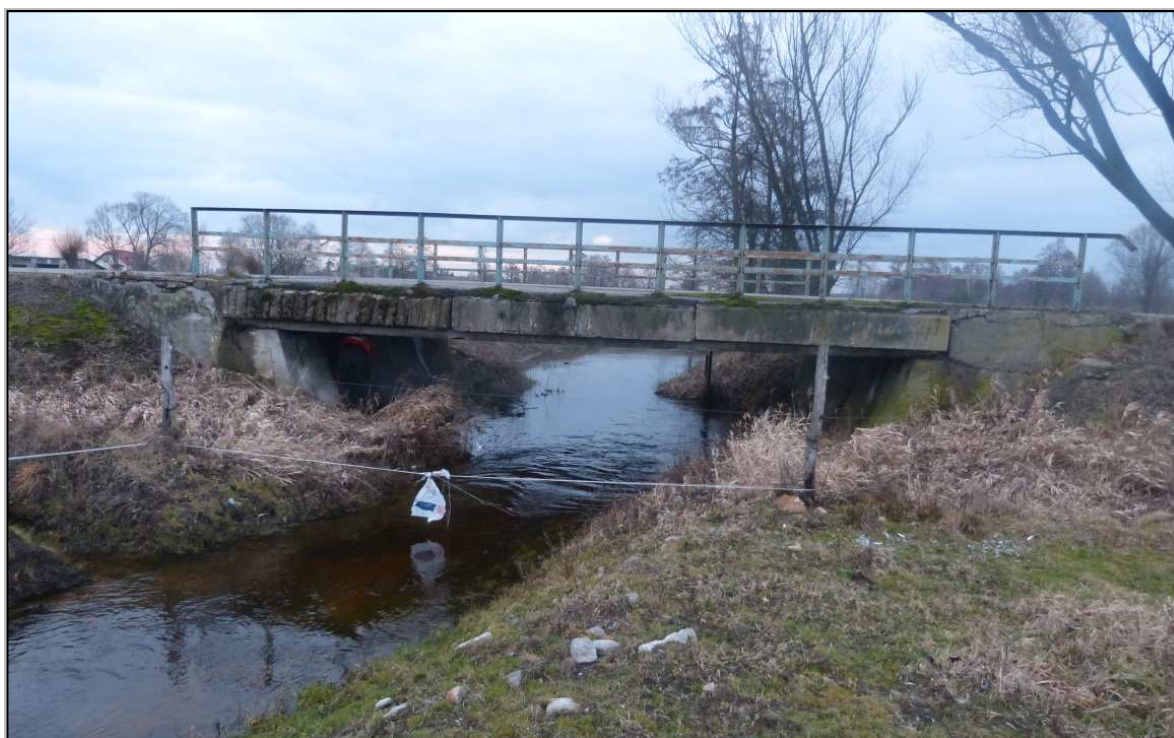
Rys. 2.2 Widok na obiekt od strony wody górnej
